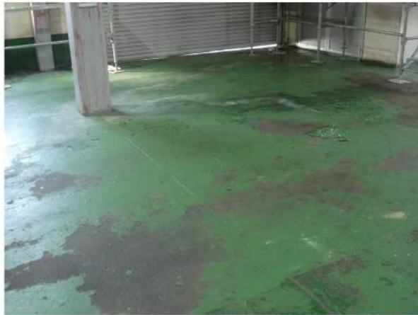
塗装床剥離洗淨
